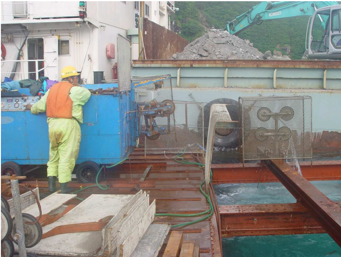
2.作業架台(足場)を製作しワイヤーソーイング機をセット 施工
