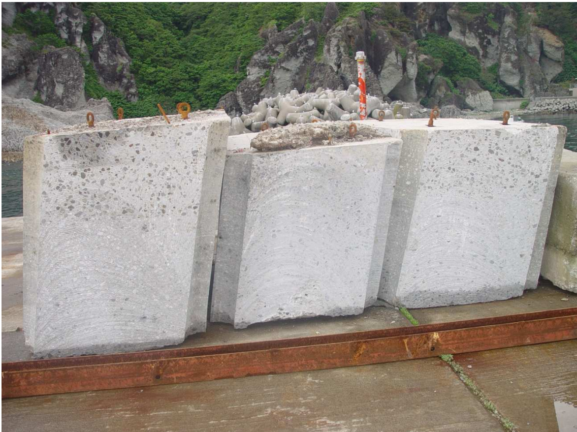
3.切断した対象物（ケーソン）を吊り上げ撤去完了
