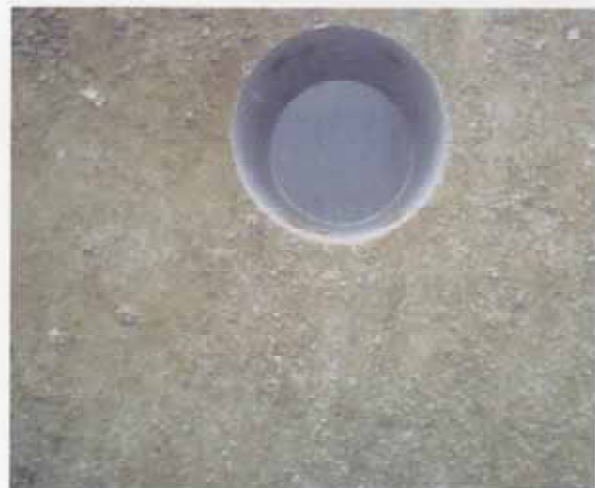
H16災沿第1号 消波堤 ケーソンワイヤーソー切断 吊り上げ用穴
