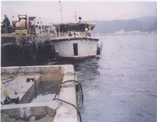
H16災沿第1号 消波堤 ケーソンワイヤーソー切断 上部工取り壊し さっ孔状況
