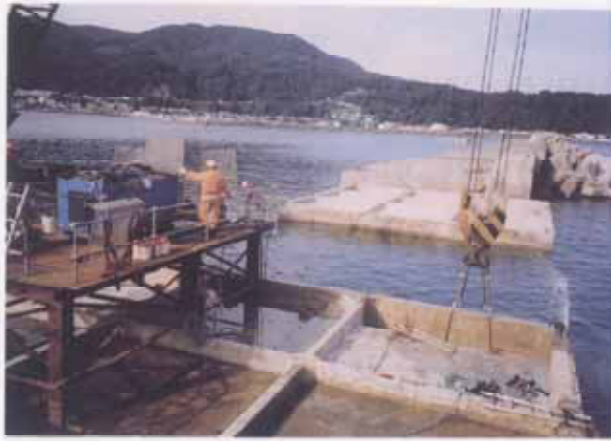
H16災沿第1号 消波堤 ケーソンワイヤーソー切断
