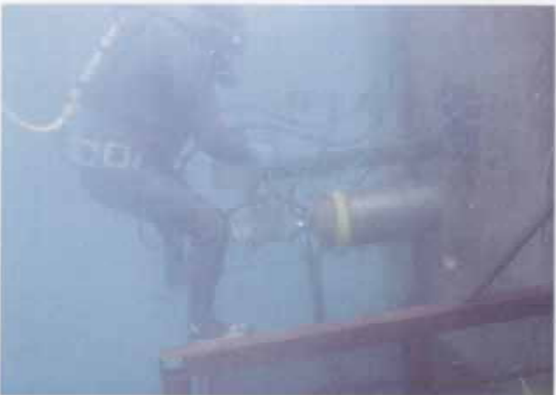
H16災沿第1号 消波堤 ケーソンワイヤーソー切断 吊り上げ用穴さっ孔
