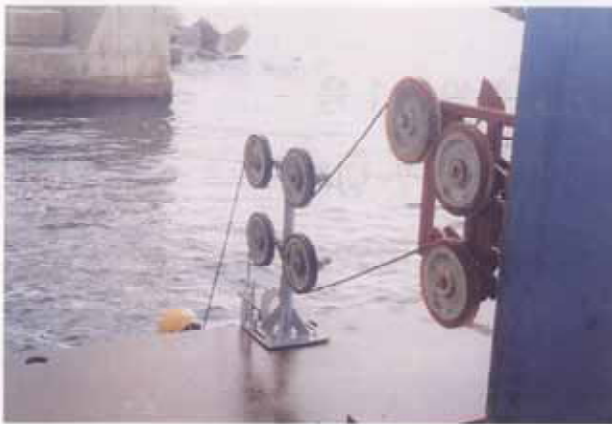
H16災沿第1号 消波堤 ケーソンワイヤーソー切断 誘導用ガイドプーリー
