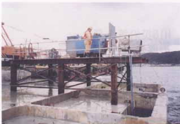
H16災沿第1号 消波堤 ケーソンワイヤーソー切断 縦切断状況
