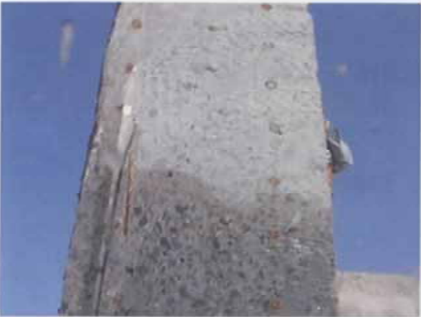
H16災沿第1号 消波堤 ケーソンワイヤーソー切断
