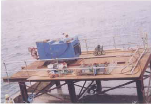
H16災沿第1号 消波堤 ケーソンワイヤーソー切断 ワイヤーソー駆動機設置
